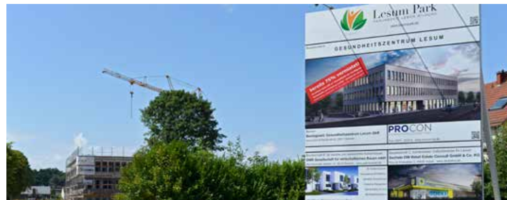
Hier entsteht das neue Gesundheitszentrum in Bremen-Nord mit 2.800 Quadratmetern.
