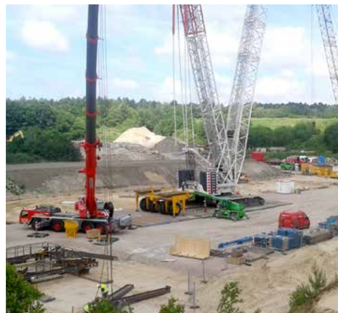
Von der hässlichen Sandgrube zum stolzen Forschungsprojekt: In Cuxhaven finden in diesem Sommer die Tests von „VIBRO-Pfahl“ statt.
